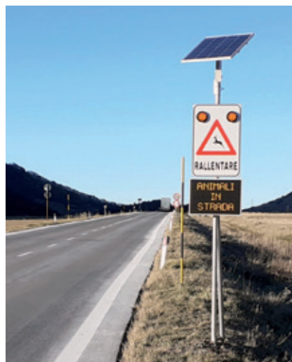
Sistema di prevenzione incidenti stradali con la fauna selvatica
